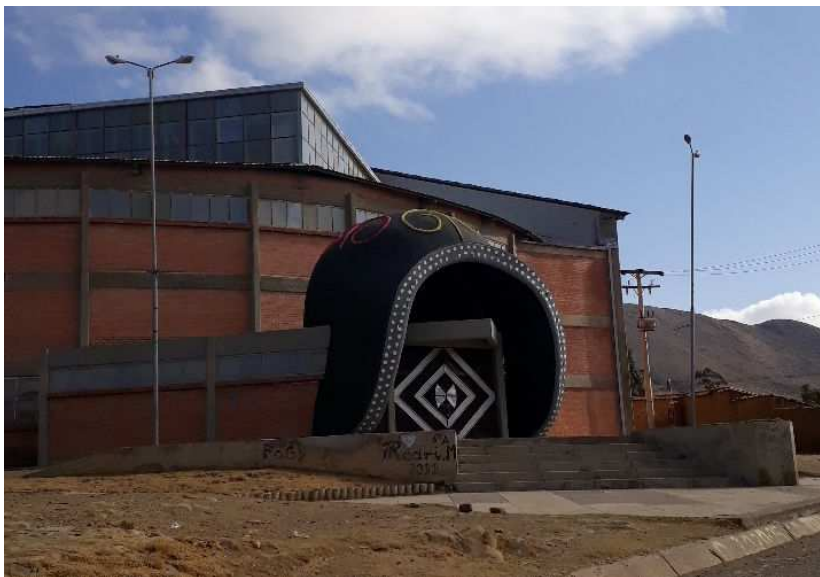
Ein Haus in Tarabuco, das den hier traditionellen Helm als Eingang hat.
